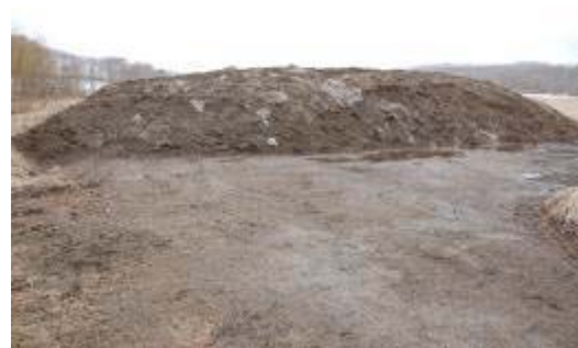
写真 2 汲み上げられたダンプ 70 台分の土砂
