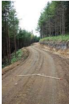
写真 2 中央を屋根型に 盛り上げた作業道
