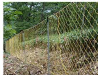
3箇所を設置した防鹿柵
