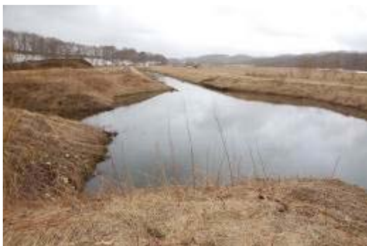
写真 1 クニクンナイ排水路の沈砂池
