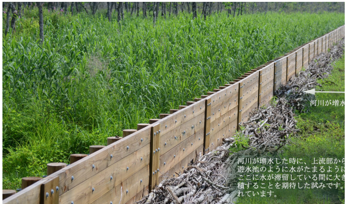
❁ フィールドの様子(土砂をためる工夫:木のついたて(人工ケルミ))
