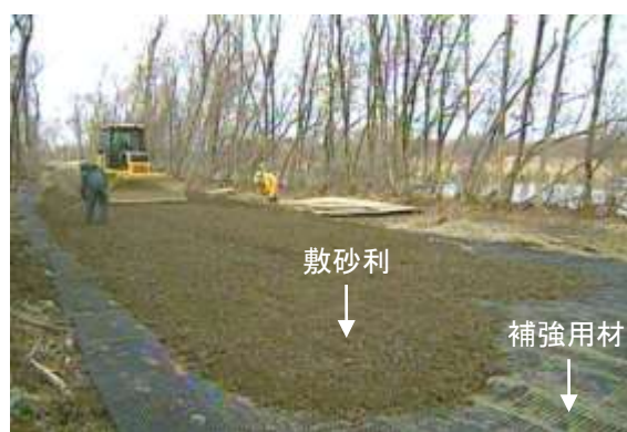
図 3-10 (例) 現況地盤圧密の軽減対策
