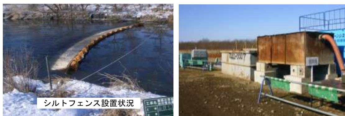
図 3-11 (例) 濁水流出・拡散の抑制（左）、沈殿池による濁水処理（右）
